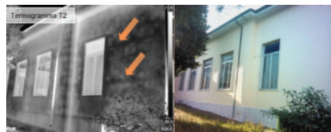
Figure 22: Termogramma T2 – in evidenza la presenza di ricorsi su murature in pietrame
